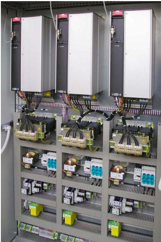
Abb. 1: 15 kW Danfoss-Frequenzumrichter mit Sinusfilter
