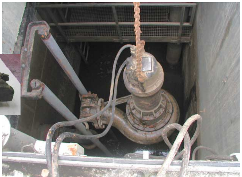
Abb. 4: Einsetzen der Pumpe
